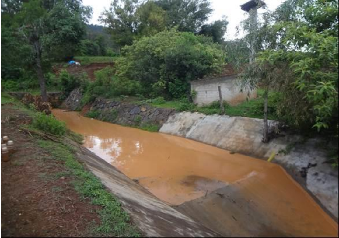
Figura 2. Aforador de garganta larga para medición de los escurrimientos.
