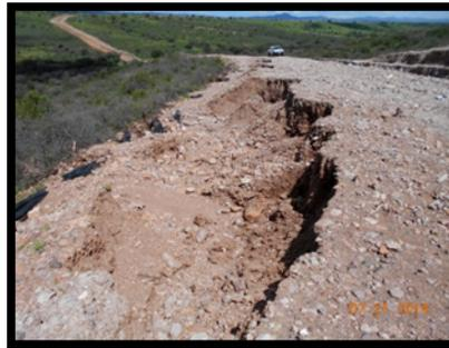
Figura 4. Evidencia de la necesidad de suavización de taludes y evitar el arrastre del suelo.
