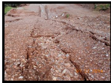
Figura 1. Evidencia de erosión laminar y necesidad de ejecutar barreras de piedra.
