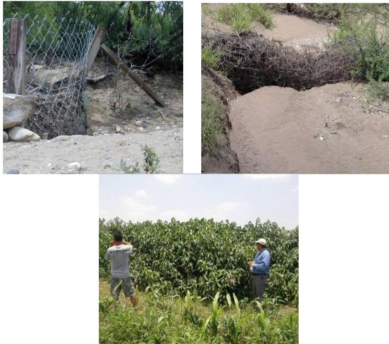
**Figura 1. Tipos de Represas filtrantes, de izquierda a derecha: malla ciclónica y ramas, malla borreguera y ramas, y barrera viva**
